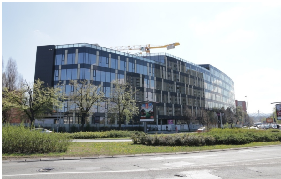
Slika 5 - Izgled zgrade u izgradnji NTP Novi Sad
